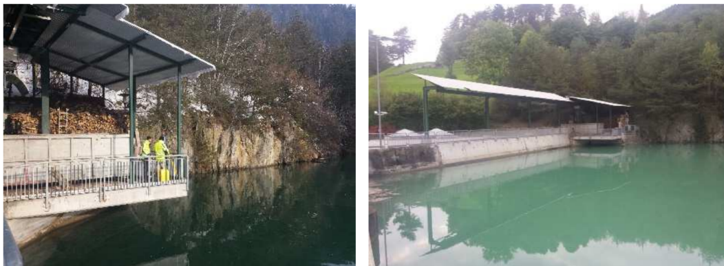
Figura 6.7: Il tratto terminale del bacino di rigurgito e l'area della presa laterale
