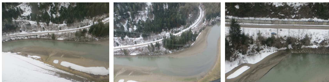
Figura 6.14: Lo stato di interrimento del serbatoio di Kniepass nel maggio 2018
