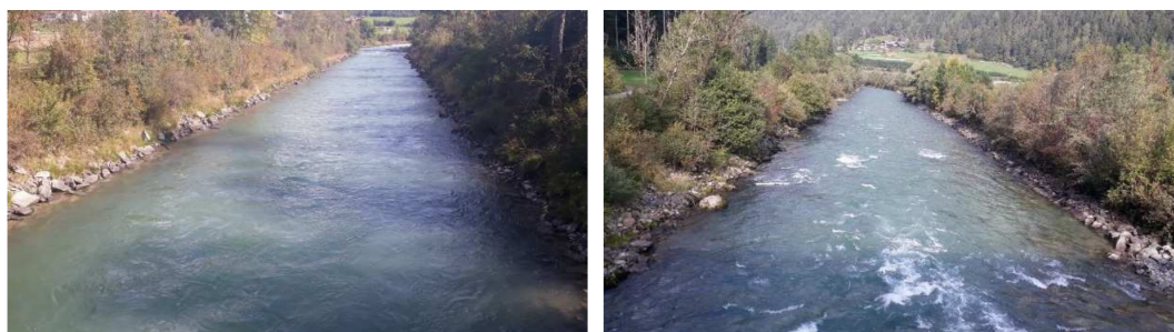
Figura 6.21: A valle di Kniepass il Fiume Rienza è regimato e canalizzato
