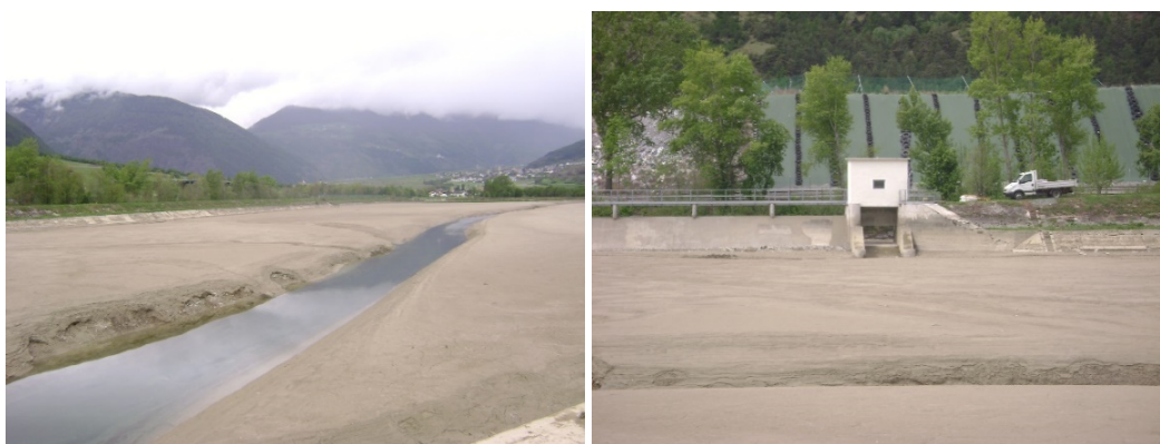
Figura 5.14: La canaletta centrale formata in seguito alla svaso ed immagine dello scarico nel Fiume Adige
