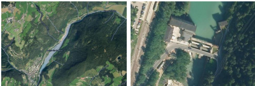
Figura 6.66: Vista aerea del bacino di Rio di Pusteria (sinistra) e ingrandimento con vista aerea della zona della diga (destra) (fonte: Google Earth )
