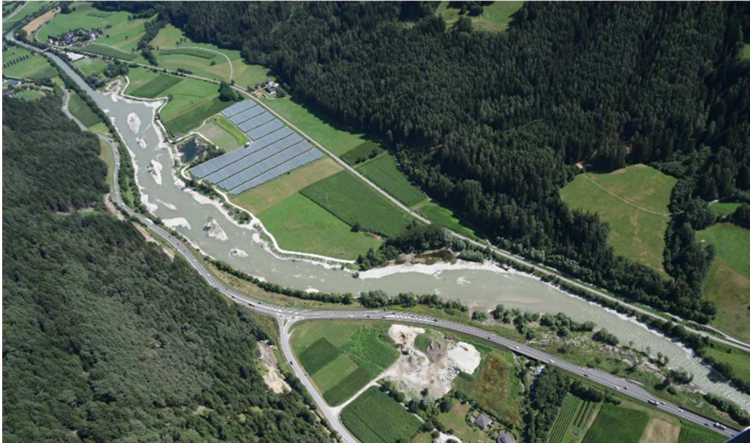
Figura 6.35: Immagine aerea dell'allargamento "Illstener Au" al termine dei lavori (fonte: Agenzia per la Protezione Civile)
