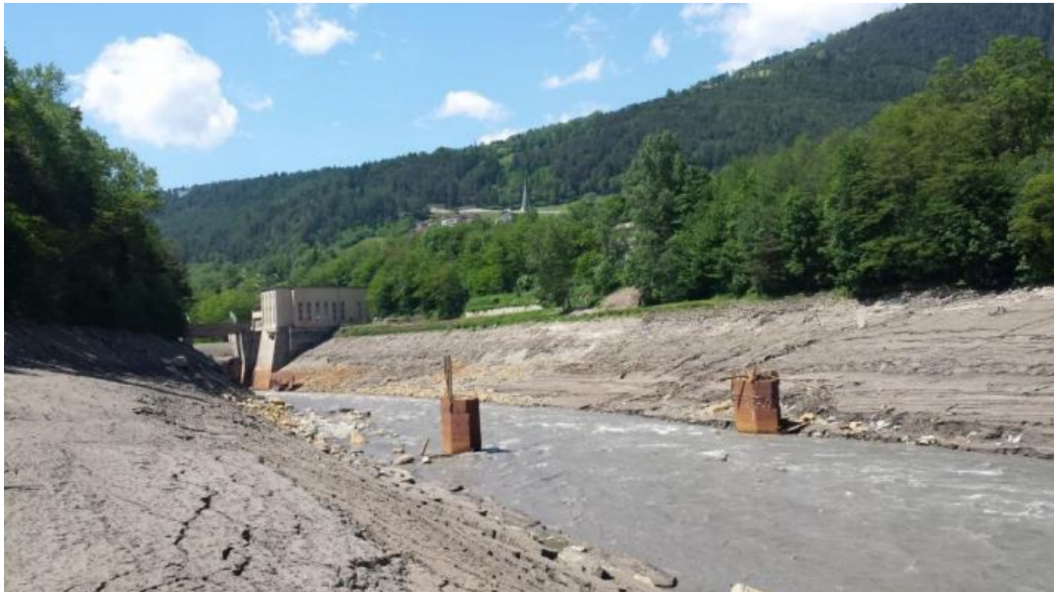
Figura 6.72: Vista verso valle (verso la diga) del bacino di Rio di Pusteria durante la fase finale delle operazioni di flushing. Si nota il notevole asporto del materiale fine
