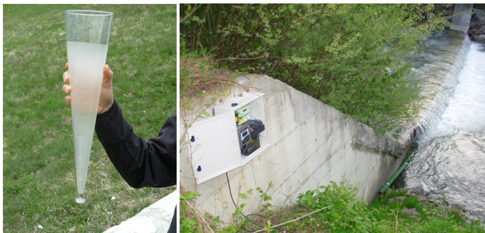
Figura 5.11: A sinistra un esempio di cono Imhoff utilizzato per i monitoraggi; a destra il torbidimetro installato dal Gestore a valle dello sbarramento di Lasa
