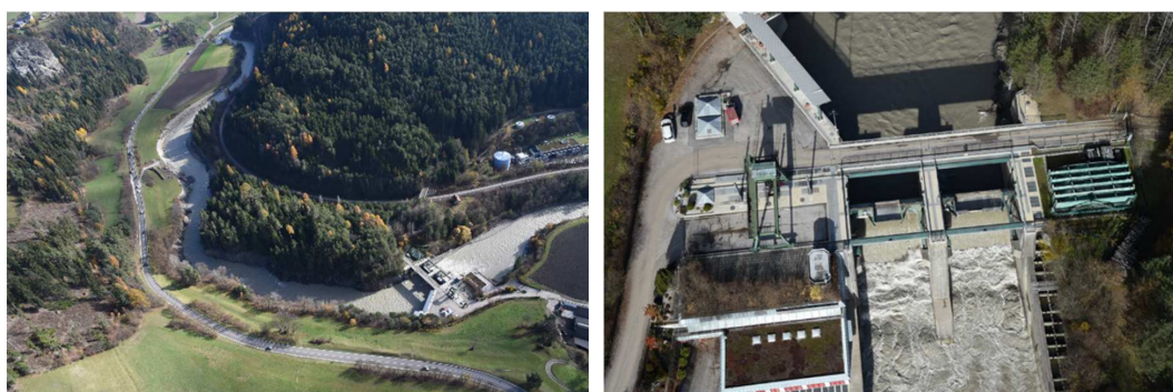
Figura 6.15: Il transito della piena "VAIA" a Kniepass e paratoie di settore completamente aperte (fonte: Agenzia per la Protezione Civile)
