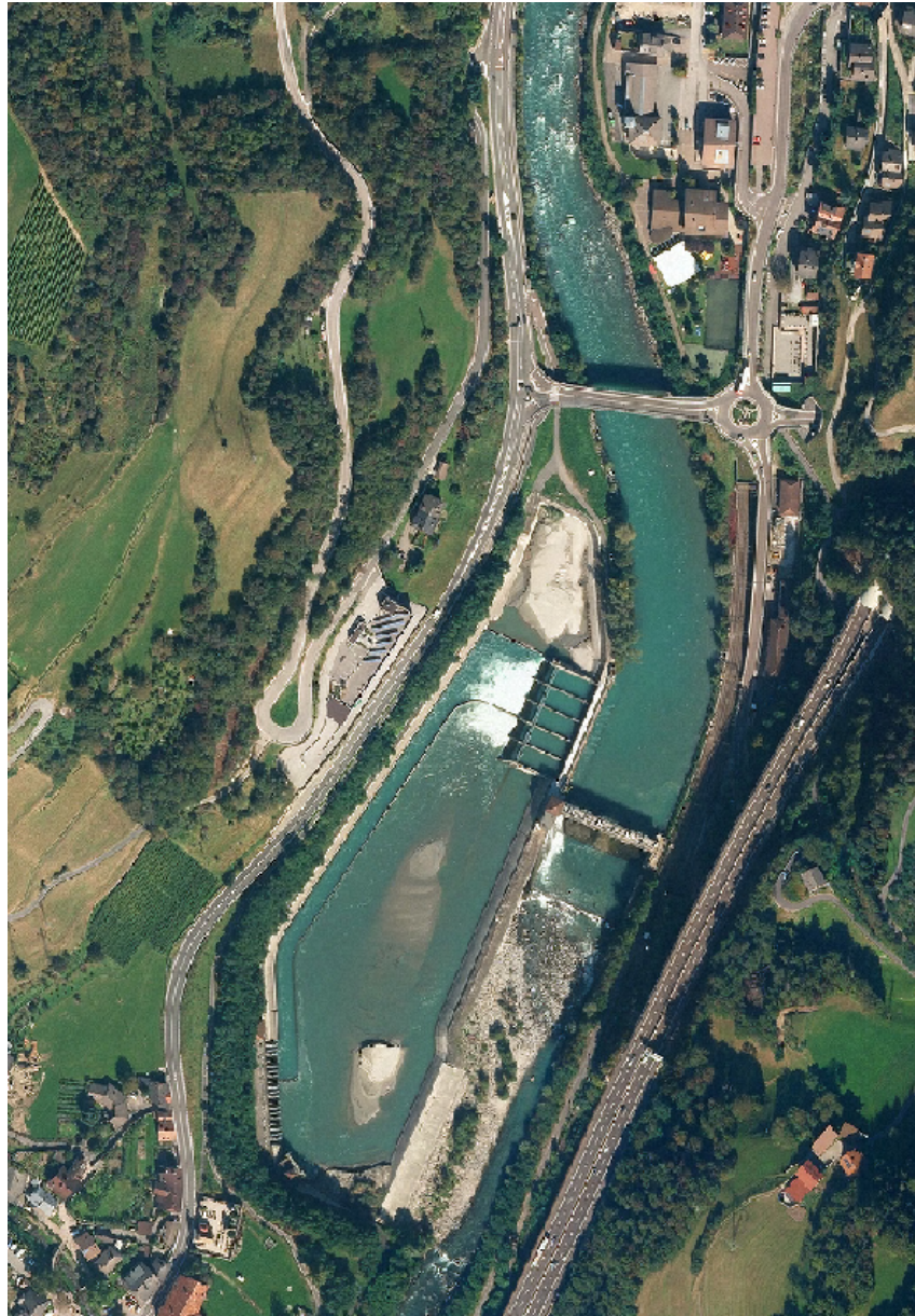
Figura 0.1: Vista aerea della traversa fluviale sull'Isarco a Colma
